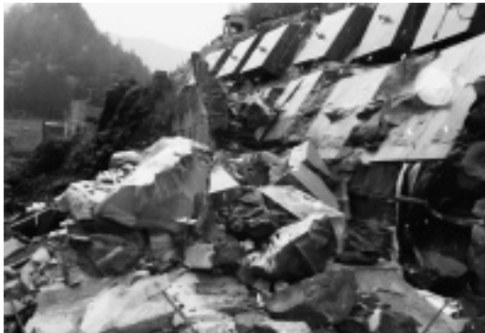
写真-1 軽量盛土崩壊
