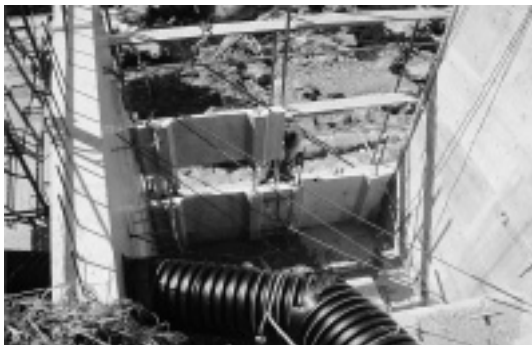
写真-3 仮設排水管設置
