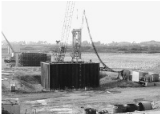
写真-3 デュアルジェットシステム設置状況 (全体)
