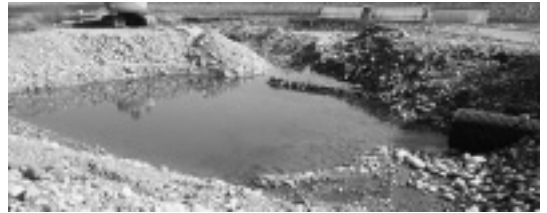
写真-5 沈砂池設置状況
