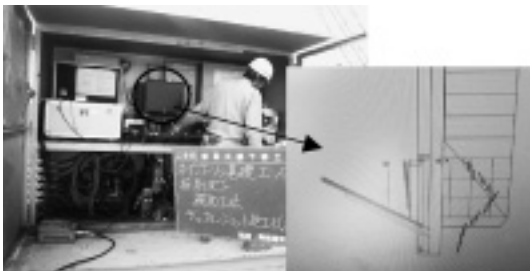
写真-4 デュアルジェットシステム遠隔操作状況
