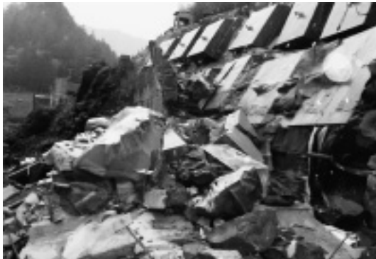
写真-1 軽量盛土崩壊
