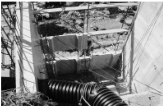
写真-3 仮設排水管設置
