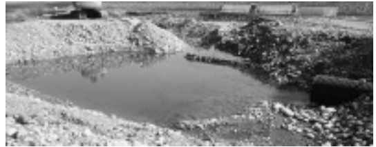
写真-5 沈砂池設置状況
