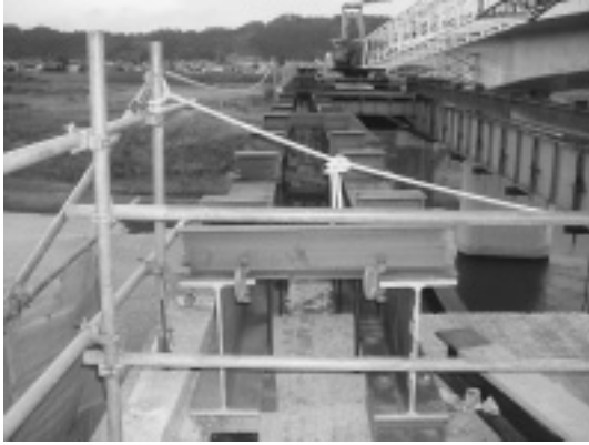
写真-4 撤去用吊桁設置状況
