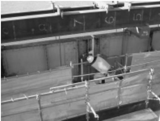
写真-5 ゲルバー部切断状況
