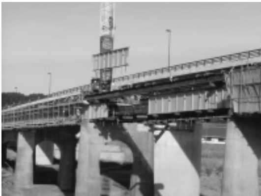
写真-6 切断主桁撤去状況
