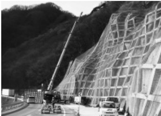
写真2 落石防止網設置状況
