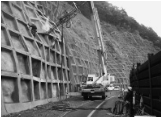
写真1 グラウトロックボルト削孔状況
