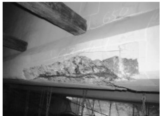
写真1 鉄筋腐食によるコンクリートの剥落
