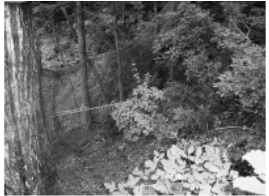
写真3 仮設落石防止柵詳細
