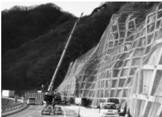
写真2 落石防止網設置状況
