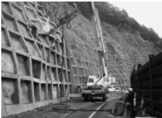
写真1 グラウトロックボルト削孔状況
