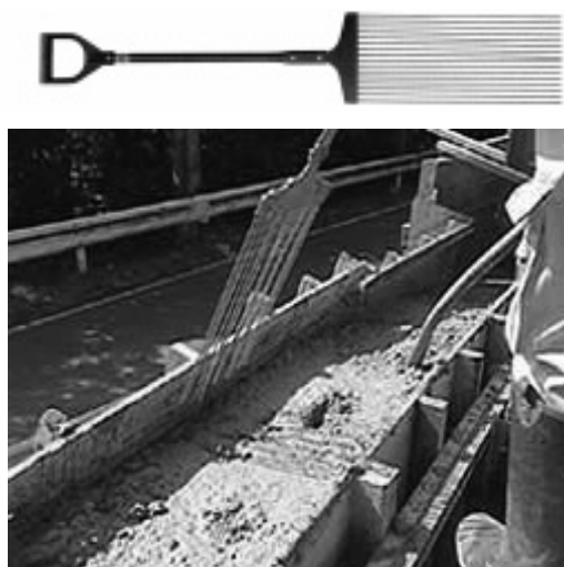
写真1 スページングによる気泡の除去状況
