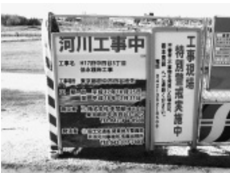
写真-3 標識、仮囲いの第三者安全対策
