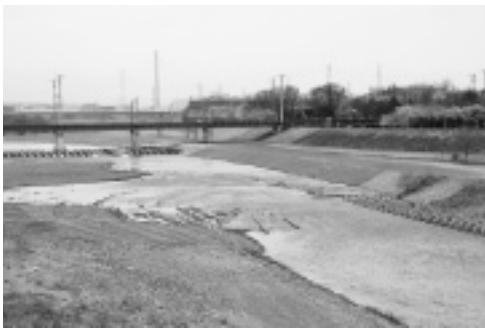
写真-1 完成写真
