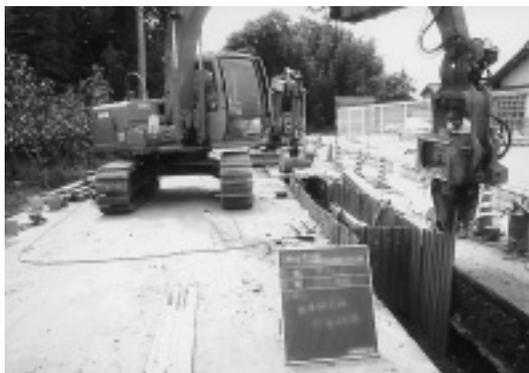
して挑みました。初日のマンホールでは3インチ5台では水が替えきらず掘削はしたものの床掘まで至らず埋め戻しました。まずポンプはシルト、砂質系の土質の為土砂を吸い込み、鋼矢板はボーリングを起こして建て込めなかったからです。現状のままでは何も始められないので、設計3.0mの矢板長を4.5mに変え機械をAパイラ0.4m<sup>3</sup>クラスに変更して協議しました。工期的にも徐々に厳しくなっているしこの地下水位では特に厳しくなるので早い結論を期待していましたが、中々指示も出ず工期延長も期待できないようでしたので、こちらから渋々承諾願いと提出しなおしました。
