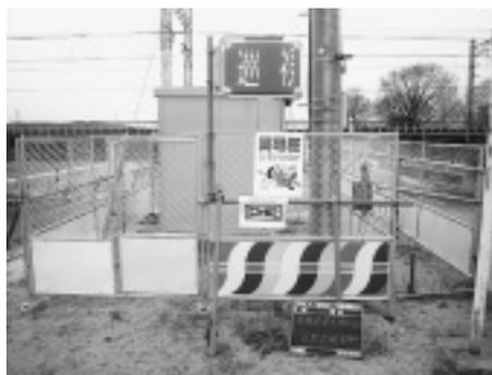
写真一 7 電光表示板による情報提供
