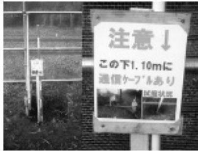
写真-4 埋設物目印看板設置状況
