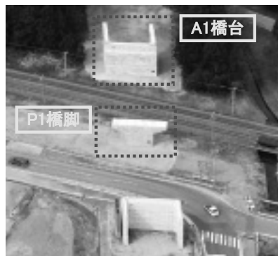
写真-1 完成写真 (A1橋台・P1橋脚)
