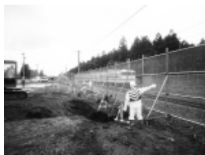
写真-5 線路防護柵設置状況
