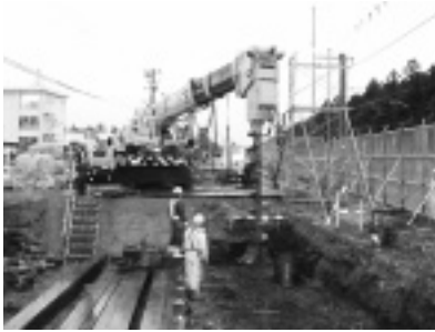
写真-2 施工状況（オーガー掘削状況）
