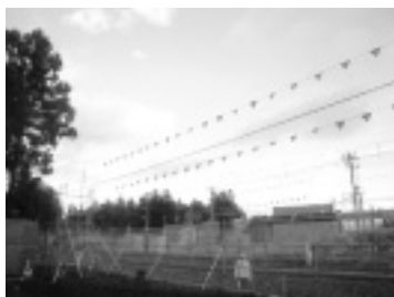
写真-6 電線建築限界線目印設置状況
