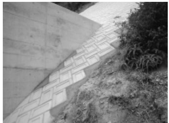
写真-2 補修完成
