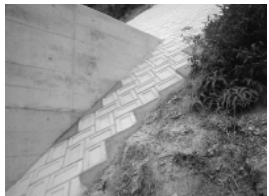
写真-2 補修完成
