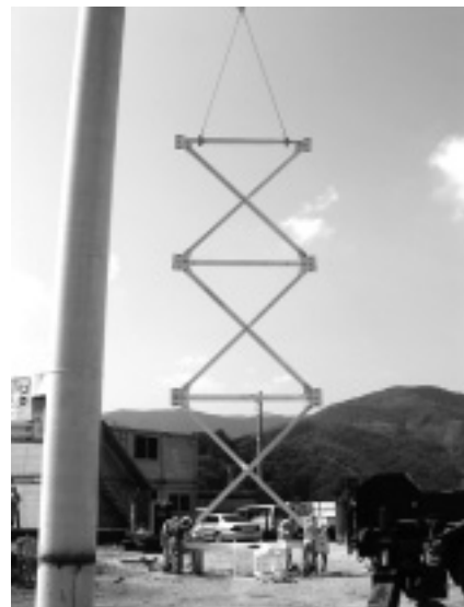
写真－4 支柱補強材組立
