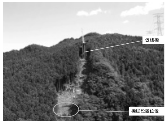
写真－2 新旅足橋下部（左岸）工事箇所全景
