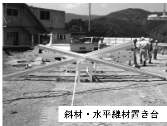
写真ー７ 斜材・水平継材置き台
