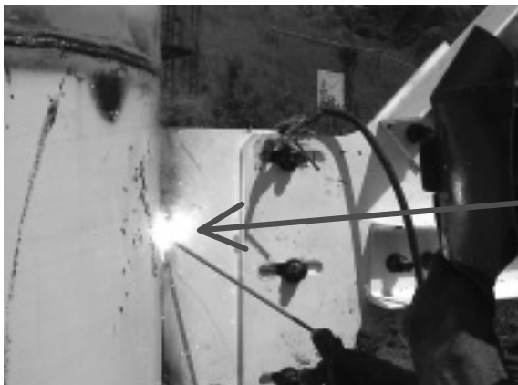
写真-6 目板溶接取付
