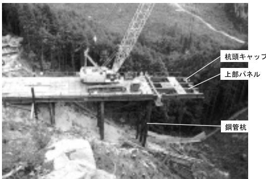
写真－1 SQCピア工法上部パネル取付け状況
