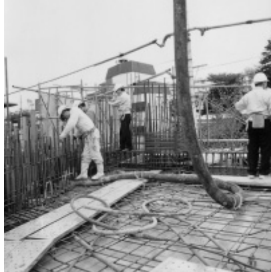
写真-1 ブームによるポンプ圧送
